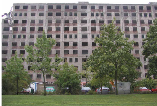
leerstehendes Wohnhaus, vor Abriß
